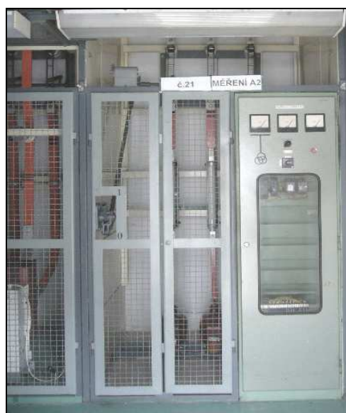
Obr. 2.8 Vývodové kobky s vypínači s SF 6 Obr. 2.9 Kobka měření napětí sběrnic
