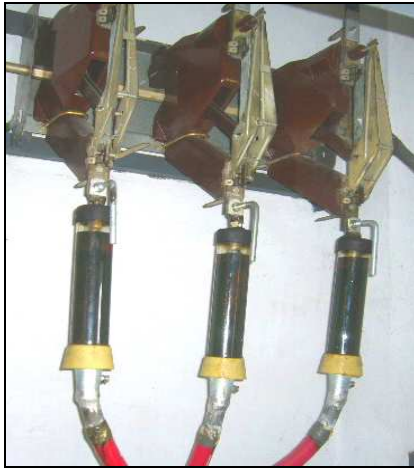
Obr. 2.4 Olejová kabelová koncovka a detail uchycení a uzemnění kovového pláště
