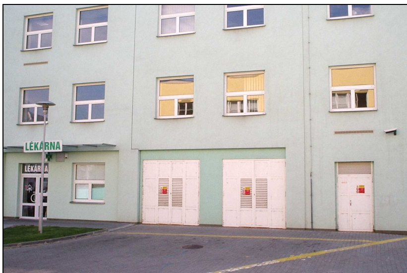
Obr. 1.3 Vestavěná transformovna
