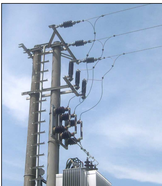
Obr. 2.1 Ukotvení vedení 22kV
