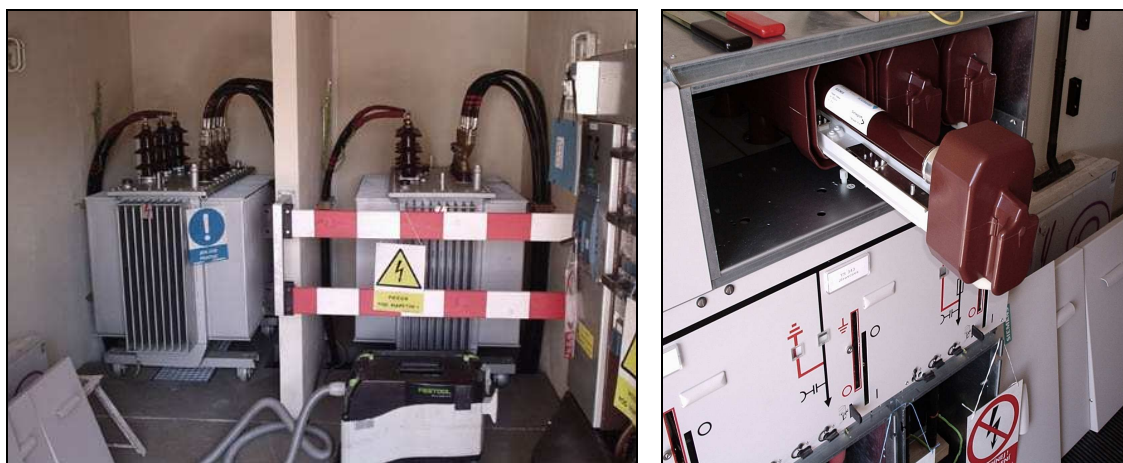
Obr. 5.8 Zajištěné pracoviště
