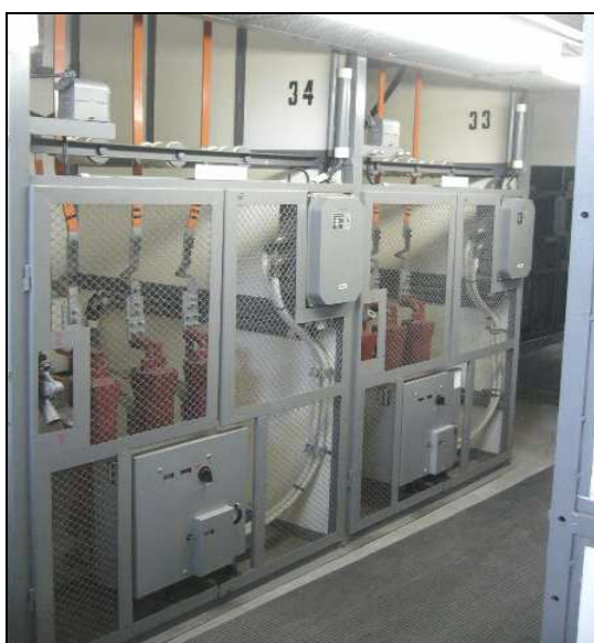
Obr. 2.8 Vývodové kobky s vypínači s SF 6 Obr. 2.9 Kobka měření napětí sběrnic
