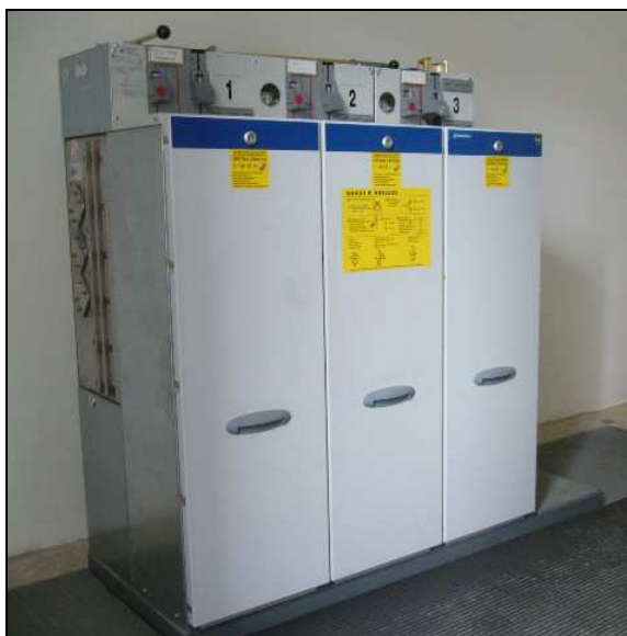
Obr. 2.6 Rozvaděč VN plněný plynem SF 6
