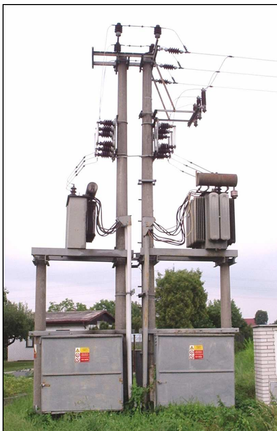
Obr. 1.1 Čtyřsloupová transformovna
