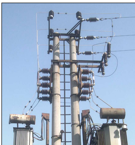
Obr. 2.2 Dvoutransfórnátorové provedení
