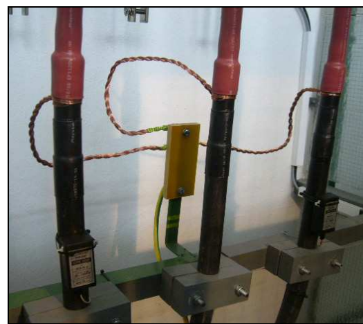
Obr. 2.5 Plastové koncovky a detail uchycení a uzemnění měděného stínění
