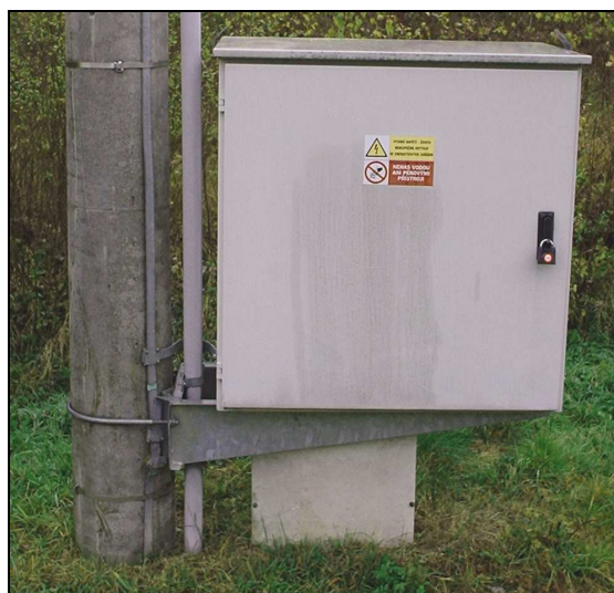
Obr. 2.3 Svodová trubka a ochranná lišta
