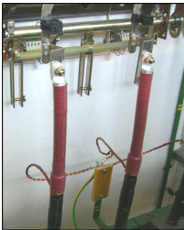
Obr. 2.5 Plastové koncovky a detail uchycení a uzemnění měděného stínění
