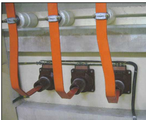
Obr. 2.10 MTI jako stěnové průchodky
